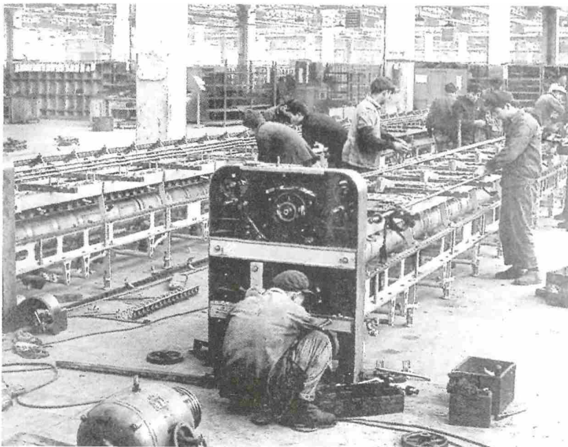
建设中的洛阳第一拖拉机制造厂
