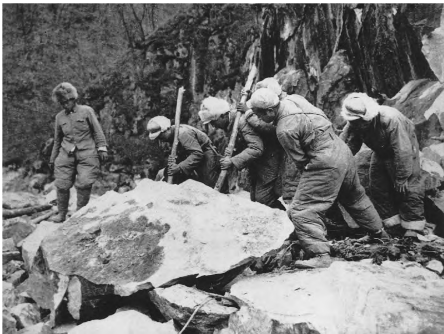
后勤兵站的工作人员在严寒的冬季修建仓库
